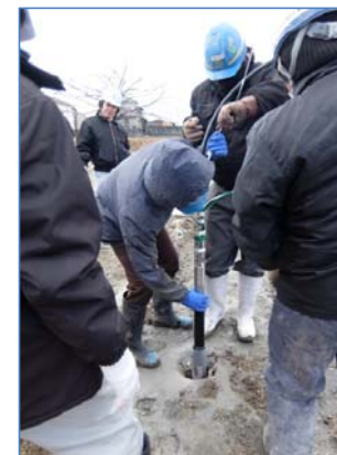
注入装置挿入状況
